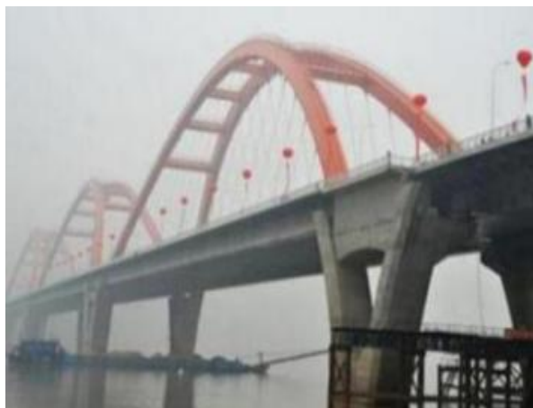
长沙湘江福元路大桥项目
